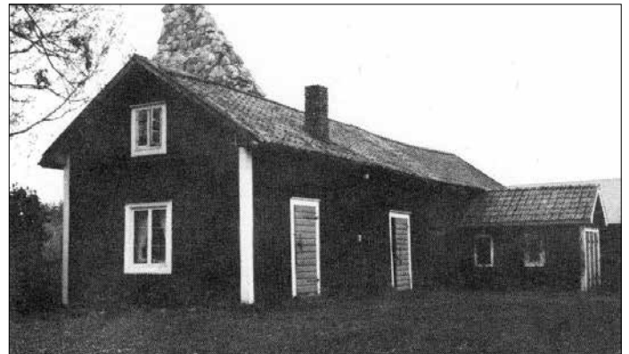
Furby drängkammare, byggd mitt 1850. Här bodde Alfred 1870.
